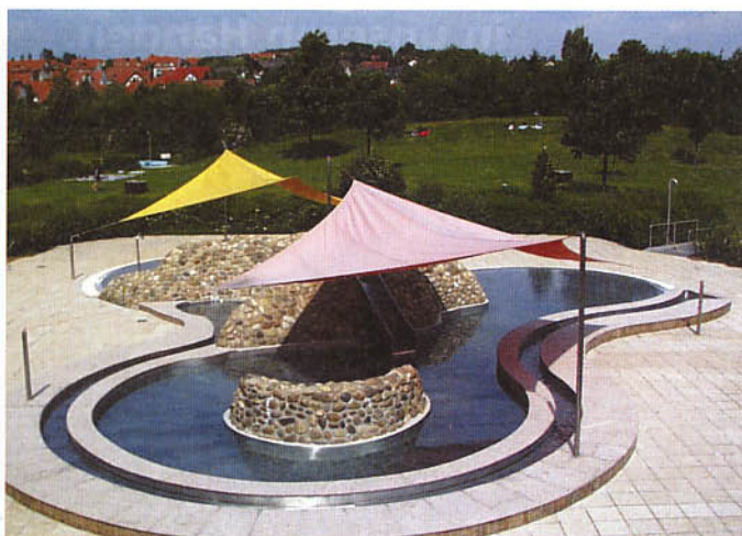
... Freibad können nach dem Umbau energiesparend betrieben werden
