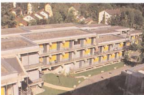
Das Objekt Studentenwohnanlage in Konstanz
